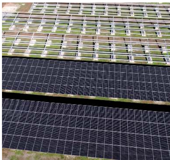
Impianto a terra. Un progetto in fase di realizzazione
